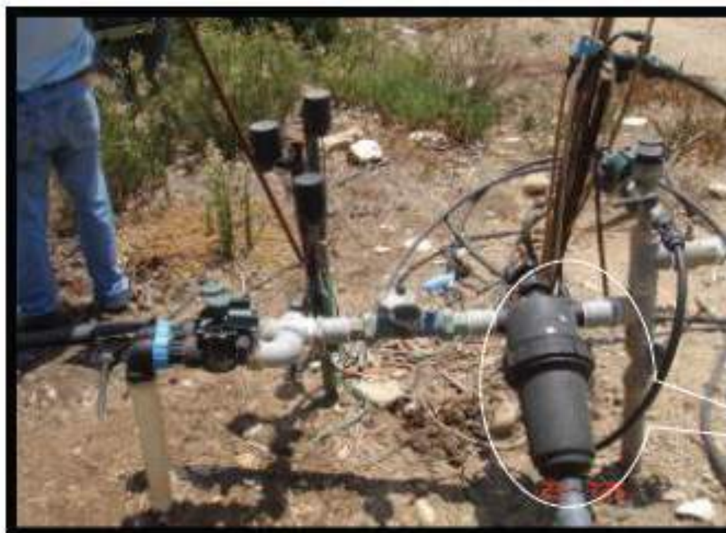
Figura 1 - Cabeceira de irrigação mostrando os sensores, válvulas automáticas, medidores, filtro, ventosas e outros equipamentos. A cor violeta da tubulação aponta se tratar de esgoto tratado
